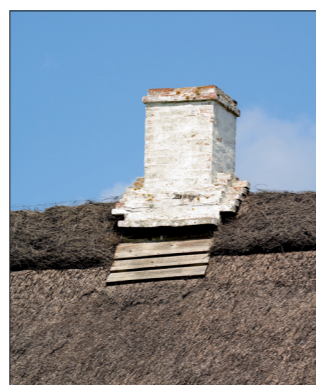
Skorsten med muret musetrappe og skotbrædder på stråtag
