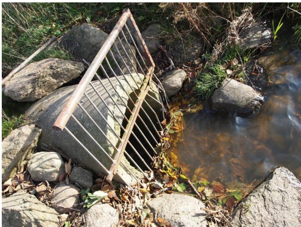
Figur 5.7: Rist ved rørløb fra dam
