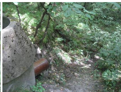
Torneværket. kaolinslemmeriet. Øverst i terrænet ses rester af bassiner og ruiner, der har huset pumper og ventiler. Bagved ses en brønd med afløb, hvorfra det overskydende vand er ledt ned ad bakken og ført videre via en kanal.
