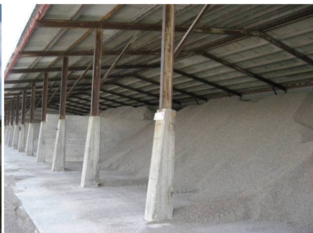
Rabækkeværket. Her ses åbne lader, som er opført over en længere tidsepoke til opbevaring af råstoffer, herunder knuste sten, som er sorteret efter størrelse.
