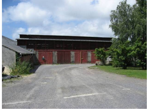
Rabækkeværket. Lagerhallerne er typisk med betonpiller og beklædningen er rødmalet træ.
