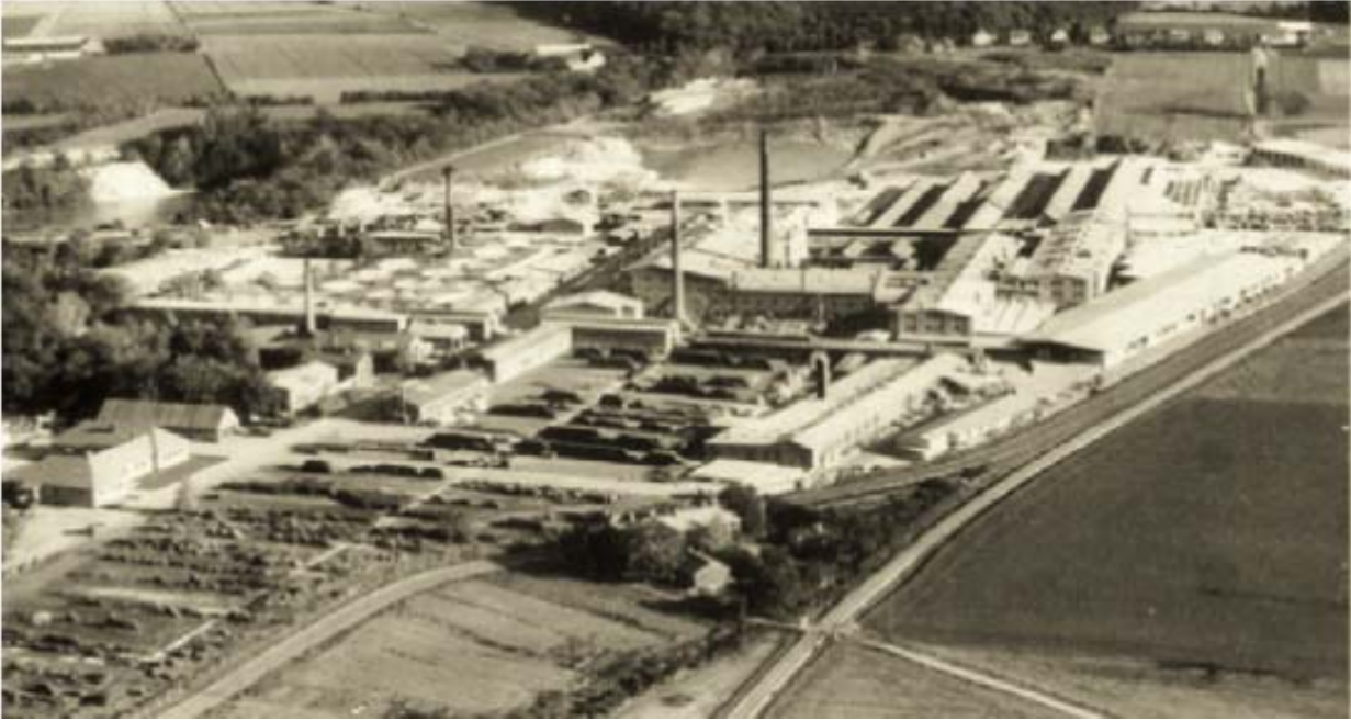
Rabækkeværket i 1955. Til venstre ses de store runde kaolinslemmekar. Midt i anlægget ses selve bearbejdningsanlægget med ovn, der på sit højeste beskæftigede 600 til 900 ansatte. Fra Heidi Pfeffer, Hasle Klinker- og Chamottestensfabrik i 150 år. Jubilæumsskrift, 1993.
