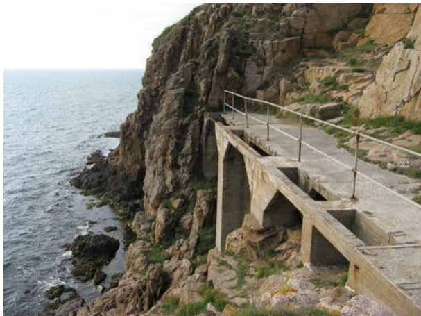
Hammerhavnen. Flere steder i området er der rester af tipvognsspor. Betonanlægget i klipperne blev brugt til at læsse restprodukter i havet.
