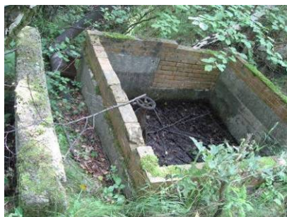
Torneværket. kaolinslemmeriet. Øverst i terrænet ses rester af bassiner og ruiner, der har huset pumper og ventiler. Bagved ses en brønd med afløb, hvorfra det overskydende vand er ledt ned ad bakken og ført videre via en kanal.
