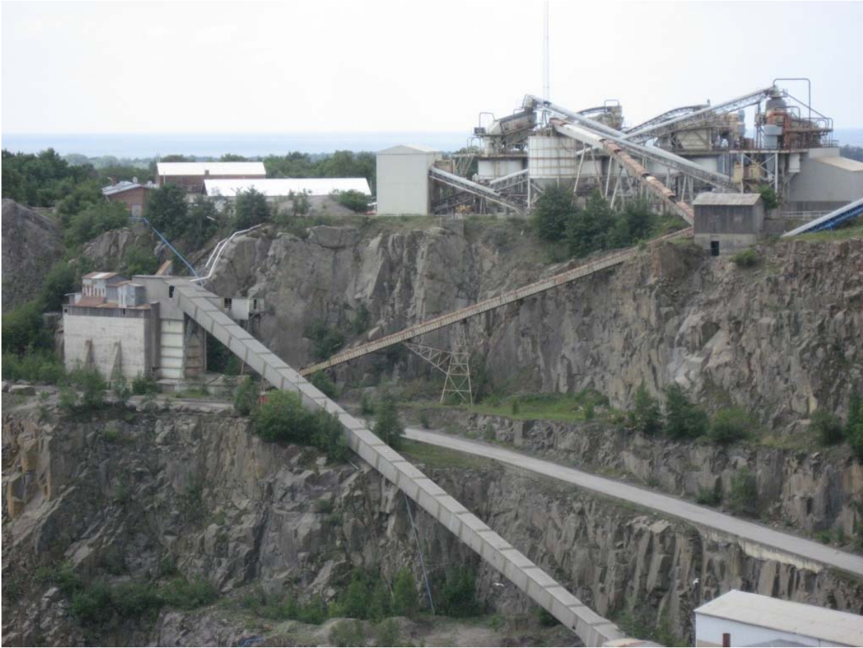
Stubbøløkken. Det enorme sorterings- og knuseanlæg.
