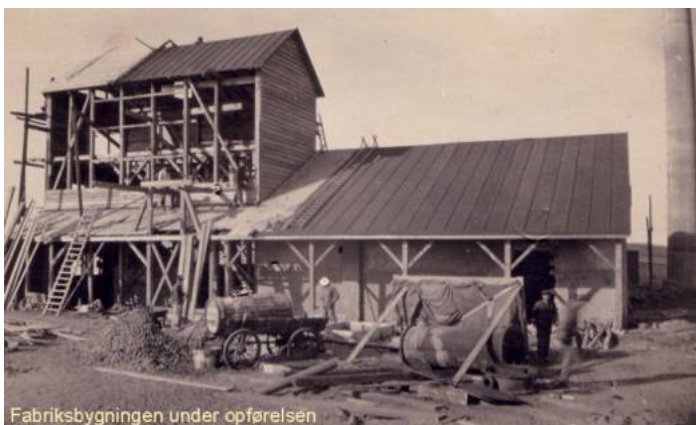
Fabriksbygningen under opførelsen
