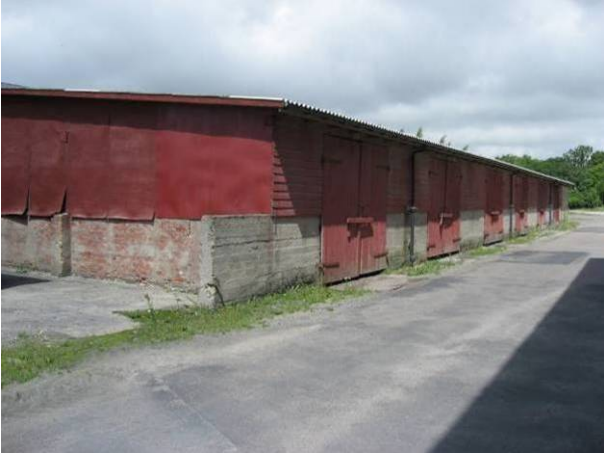
Rabækkeværket. Lagerhallerne er typisk med betonpiller og beklædningen er rødmalet træ.
