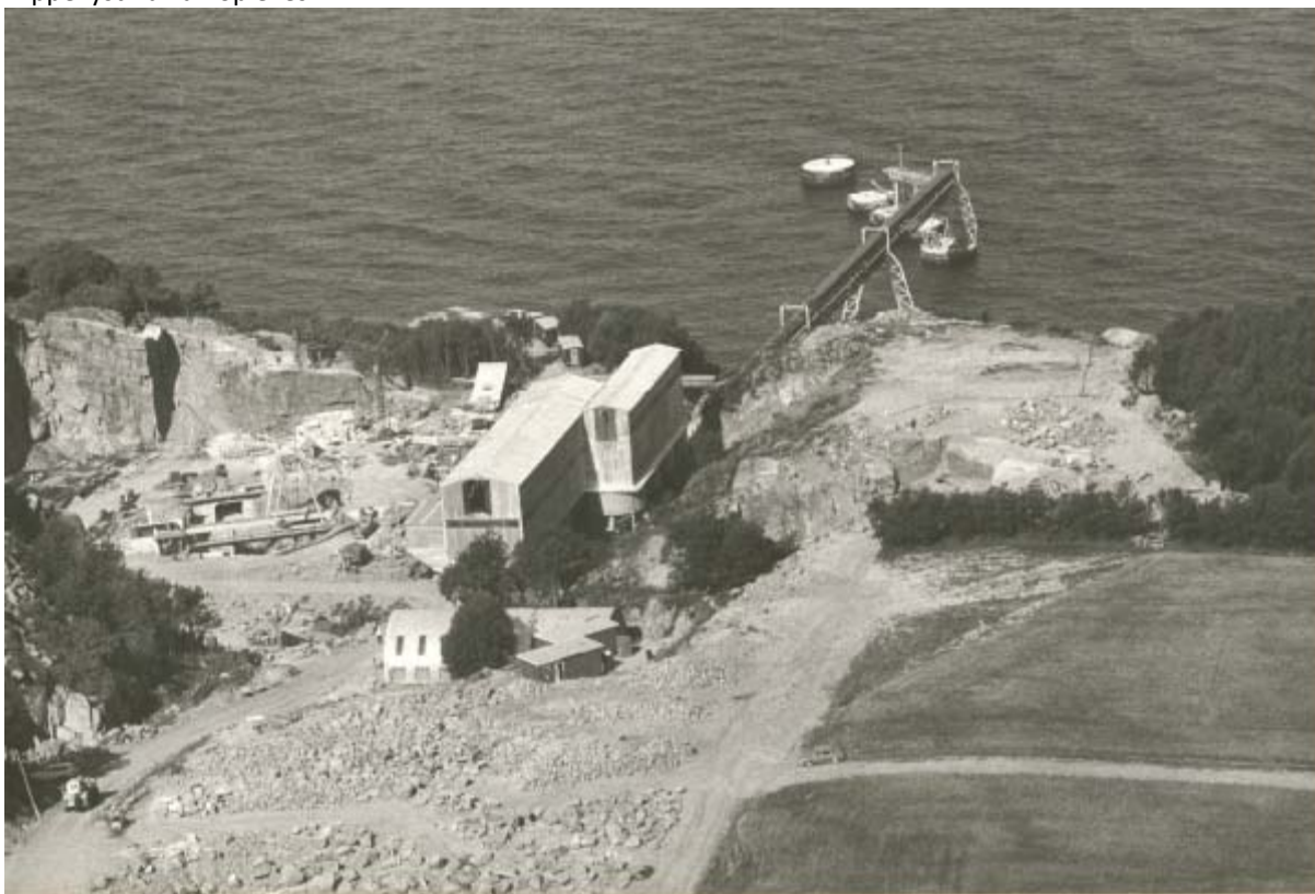
Historisk billede af Vangbruddet. Produktionsanlægget der via et svævende transportbånd førte stenmaterialet til flydepontoner, hvorfra pramme kunne transportere det videre. Kilde: Bornholms Museum.
