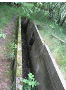
Torneværket. kaolinslemmeriet. Øverst i terrænet ses rester af bassiner og ruiner, der har huset pumper og ventiler. Bagved ses en brønd med afløb, hvorfra det overskydende vand er ledt ned ad bakken og ført videre via en kanal.
