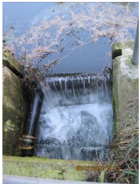
Figur 1.4. Øverst billede er et kort over projektområdet. Nederst til højre ses den eksisterende fiske-trappe, som er meget smal og med kort afstand mellem trinene. Til gengæld er trinene ikke særligt høje. Som det fremgår af billedet, er vandløbet lige før trappen hævet med tre små bassiner i selve vandløbet.
