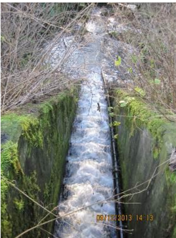
Figur 1.4. Øverst billede er et kort over projektområdet. Nederst til højre ses den eksisterende fiske-trappe, som er meget smal og med kort afstand mellem trinene. Til gengæld er trinene ikke særligt høje. Som det fremgår af billedet, er vandløbet lige før trappen hævet med tre små bassiner i selve vandløbet.
