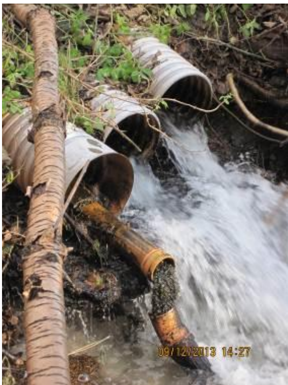
Figur 1.5. Øverste billeder er dam nummer to. Billedet til venstre viser udløb fra dam nummer to med 3 stk. Ø 20 plastikrør og ålepas. Billede til højre viser vandløbet nedstrøms dam nummer to.
