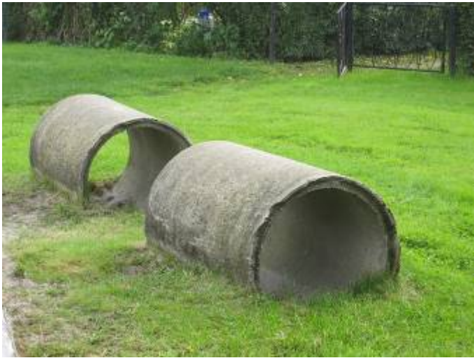
Ældre betontunneller Fiernet
