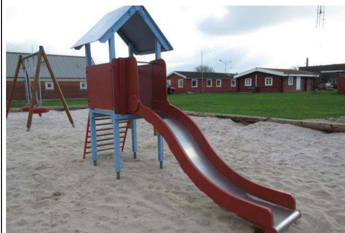
2005 – Tress legestativ med rutsjebane 2013 – Renoveret og malet 2017 – råd i rutsjebanen ved udløbsområdet jf inspektørrapport 2018 – Renoveret og malet. Ny rutsjebane
