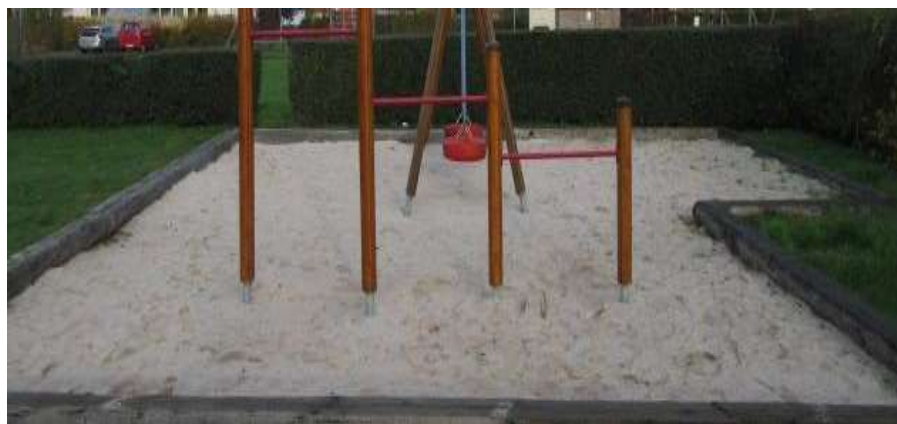
2011 – Hags kolbøttestativ model 155793 2013 – Renoveret og malet 2017 – mangelfuld udstrækning af faldunderlag på ene side af kolbøttestang
