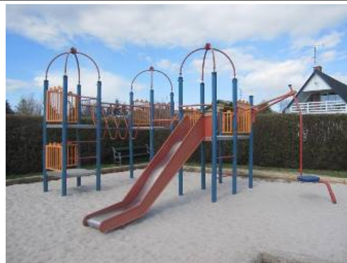
2017 – mangelfuld udstrækning af faldunderlag på den ene side af faldunderlaget jf inspektørrapport.
