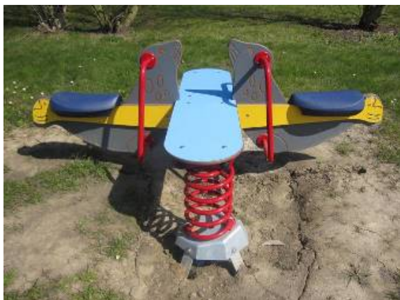
2009 – Hags vipperedskab model Moses 121692 2015 – fjedre blotlagt
