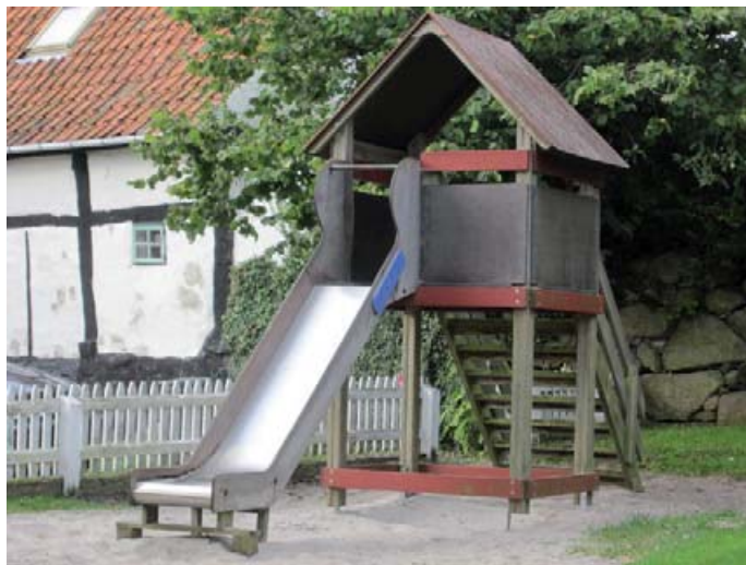
2009 – Reparationer og maling af ældre TR redskab
