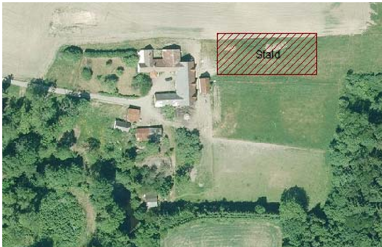
Figur 1. Luftfoto af Lærkeshøj med ny staldbygning indtegnet med rød skravering (bilag fra ansøgning).
