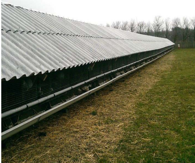
Foto 4. Åben minkhal med gyllerende og uden tagrende
