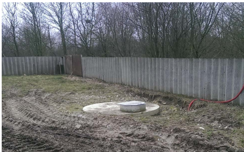
Foto 6. Nyetableret fortank på 12 m 3 (lovliggørelse)
