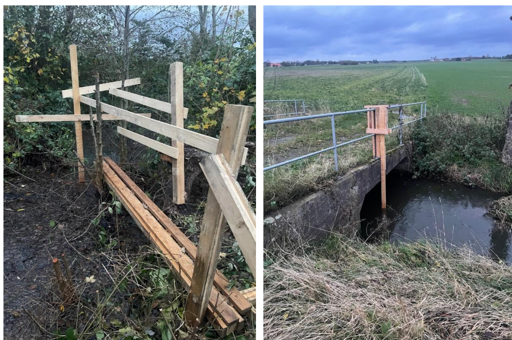
Figur 5.2 Vandstandsbrædder i grøft og Grødby Å
