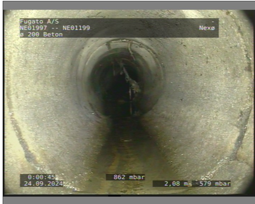
Foto: 1_2A 2,08m, Konstruktionsændring klasse 0, Materialeændring
