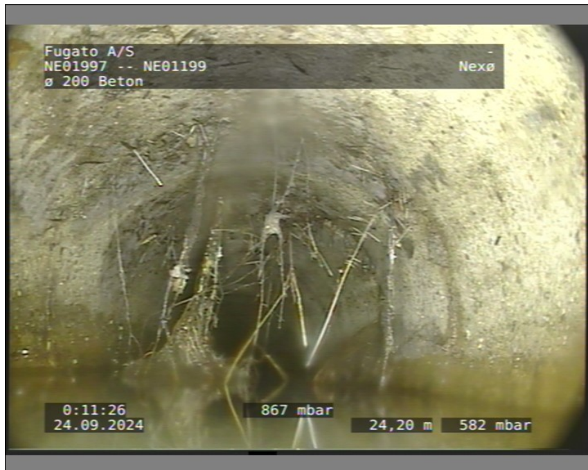
Foto: 1_10A 24,2m, Rødder klasse 3, fra urref 12 til urref 6, Fine rødder
