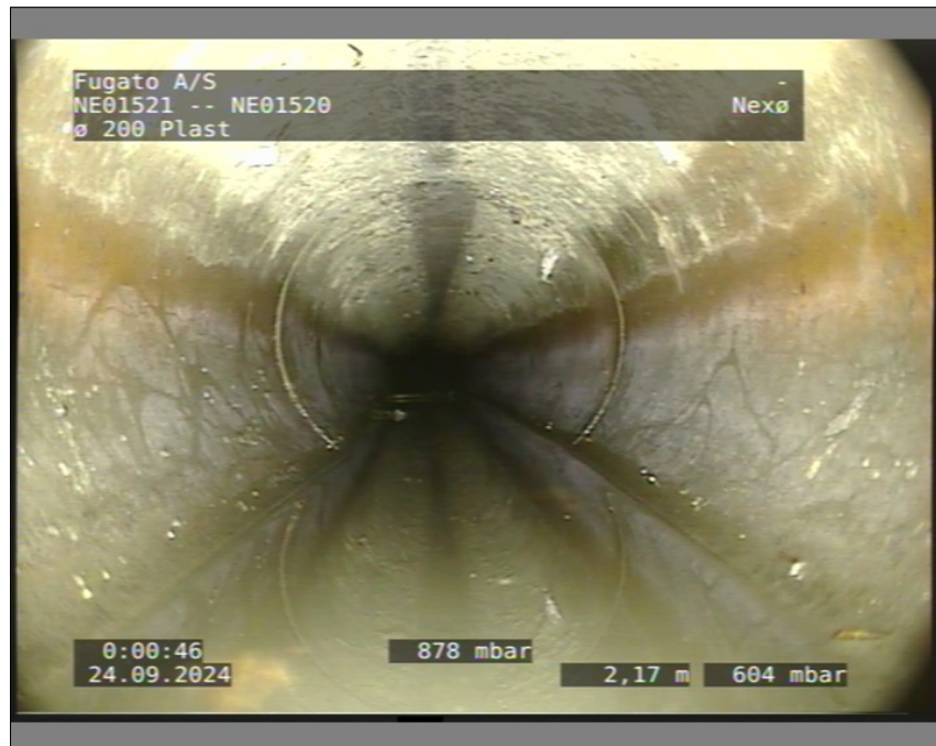
Foto: 2_3A 2,17m, Konstruktionsændring klasse 0, Materialeændring, Dimensionsændring
