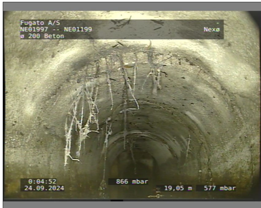
Foto: 1_8A 19,05m, Rødder klasse 1, fra uref 9 til uref 6, Fine rødder
