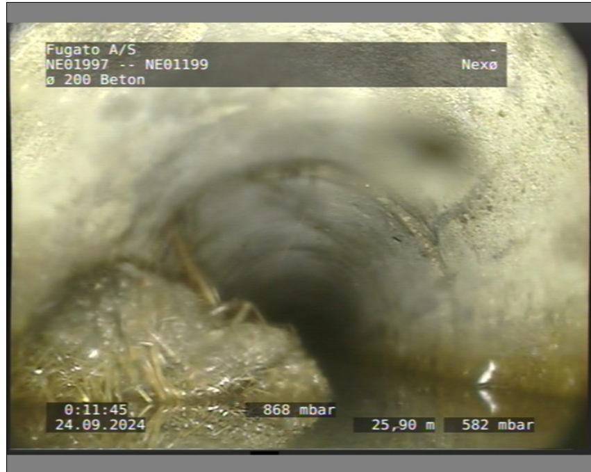
Foto: 1_11A 25,9m, Rødder klasse 4, fra urref 9 til urref 3, Fine rødder, Rodklump
