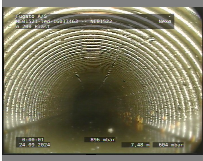
Foto: 5_5A 7,48m, Bemærkning
