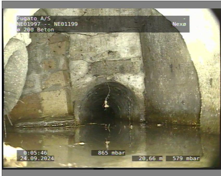
Foto: 1_9A 20,66m, Bemærkning
