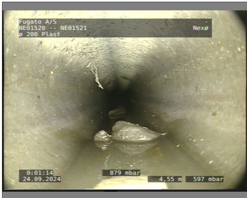
Foto: 3_2A 4,55m, Aflejrning klasse 3, fra urref 9 til urref 3, Sand/Grus
