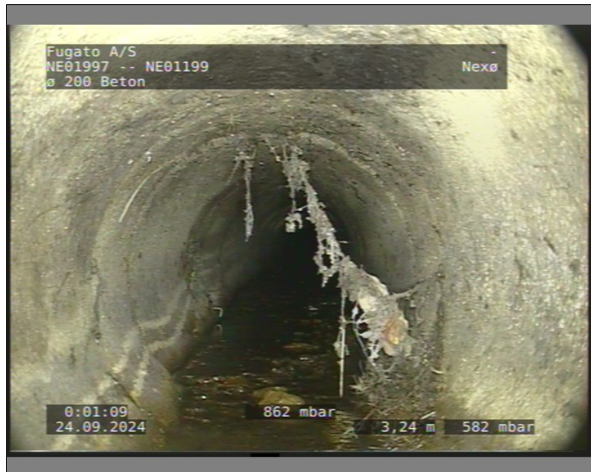
Foto: 1_3A 3,24m, Rødder klasse 1, fra urref 12 til urref 6, Fine rødder
