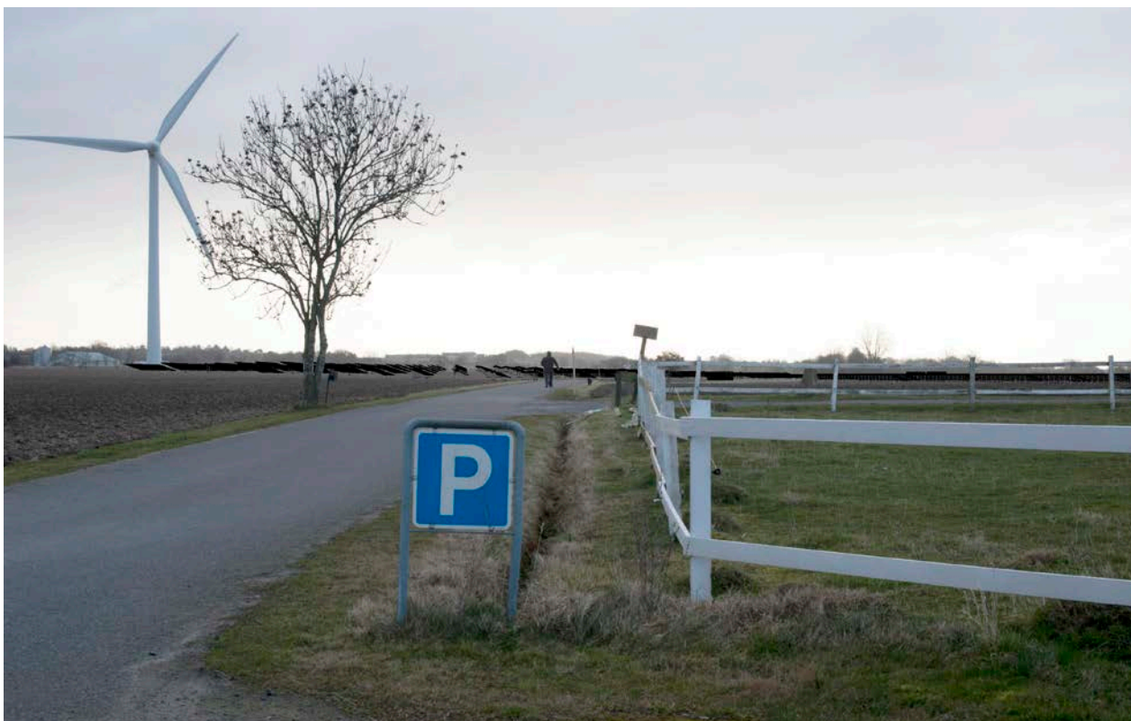
Figur 4: Visualisering. Udsigt mod øst fra Bodelyngsvejen mod øst. Anlægget vises som nyetableret uden skærmende beplantning. Solcelleanlægget øger udsigtens i forvejen tekniske præg.
