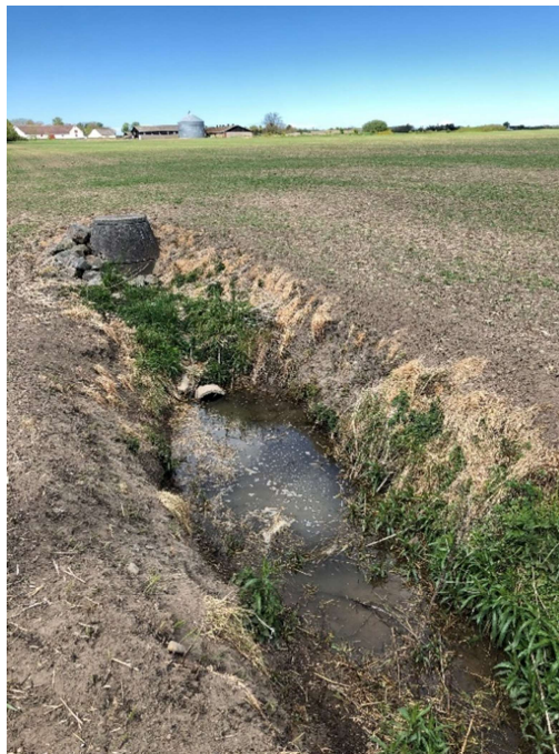
Billede af brønden i opstrøms del af grøften.
