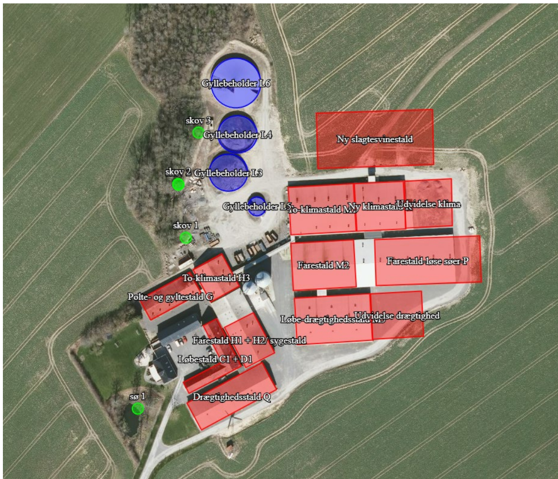
Figur 7. Anlægget på St. Muregaard.
