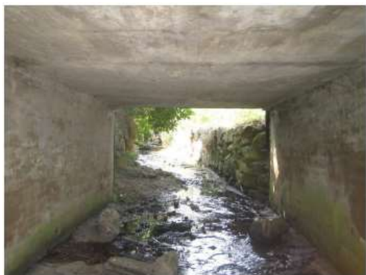
3. Bærende overbygning, set mod syd.
