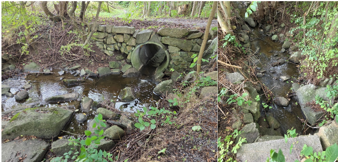
Figur 3 - Billede taget ved besigtigelse den 15.09.2025. Venstre: Viser udløb. Højre: viser indløb.
