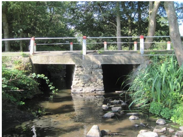
Østfacade, sideudvidelse i form af insitustøbt betonpladebro
