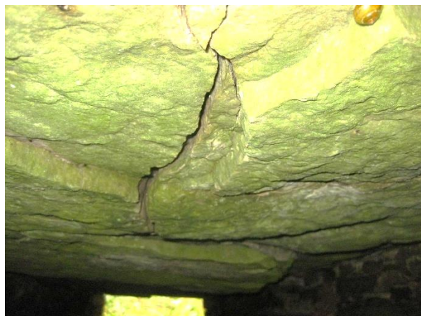
Underside brodæk, brud i bærende stenkiste-overligger
