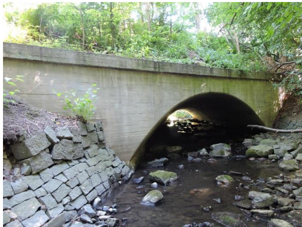
Vestfacade. Erosion og skred i skråningssikring.
