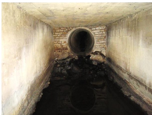
Underside bro set mod syd. Overgang ml. betonrør og pladebro.
