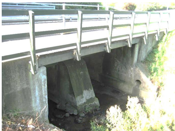
Nordfacade. Der ses hvide gennemsvninger og underskyldning af understøtninger og fløje
