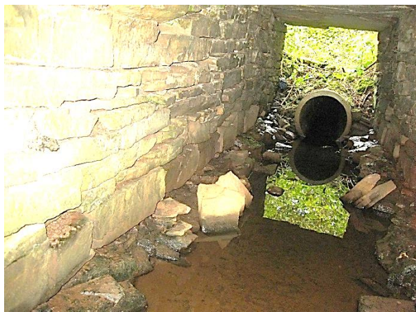
Underside bro set mod nord. Overgang ml. betonrør og stenkistebro
