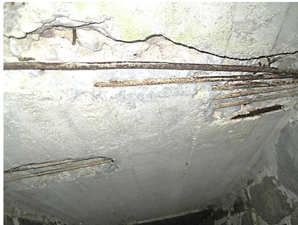
Sideudvidelse i øst, underside betonpladebro har omfattende afskallinger med synlig og tæret armering.
