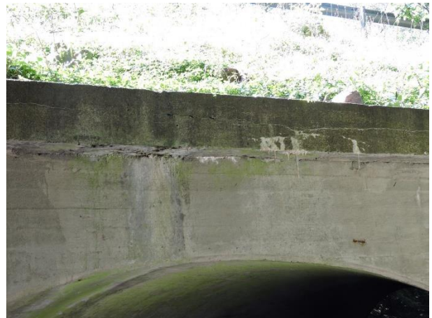
Østfacade, grove revner med gennemsvinger og hvide udfældninger.
