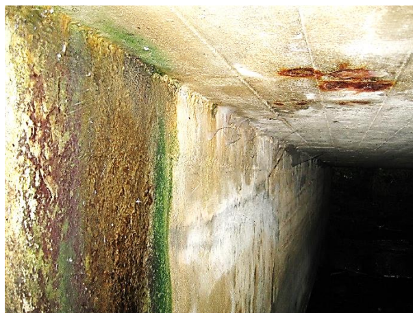
Endevederlag og bærende overbygning i NØ med gennemsvninger og brune udfældninger.
