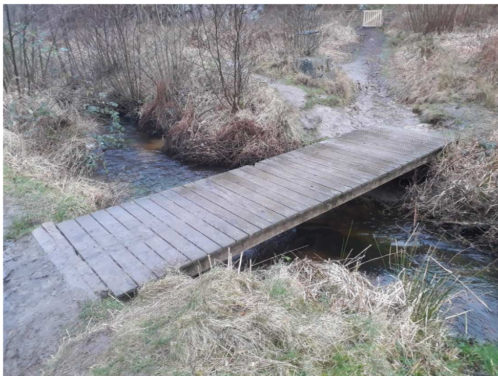
Eksisterende bro ved Fuglesangsrenden fjernes.
