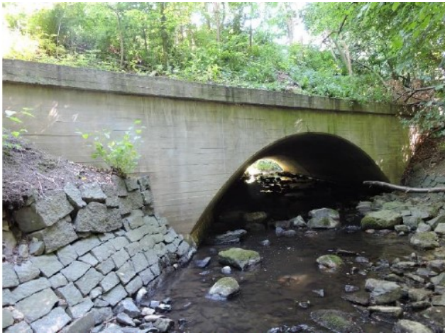
Vestfacade. Erosion og skred i skråningssikring.
