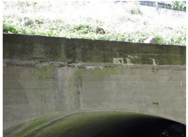
Østfacade, grove revner med gennemsivninger og hvide udfældninger.
