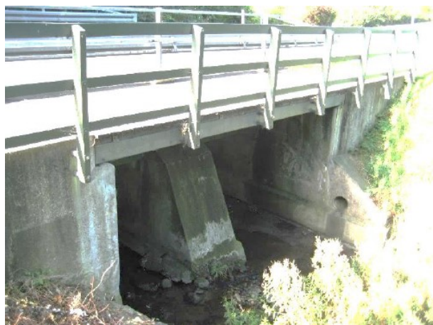
Nordfacade. Der ses hvide gennemsvivninger og underskyldning af understøtninger og fløje
