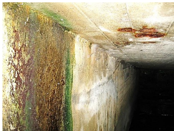
Endevedertag og bærende overbygning i NØ med gennemsvivninger og brune udfældninger.
