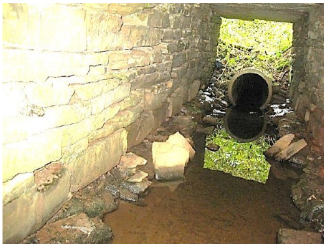
Underside bro set mod nord. Overgang ml. betonrør og stenkistebrø
