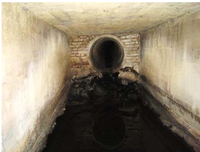
Underside bro set mod syd. Overgang ml. betonrør og pladebro.
