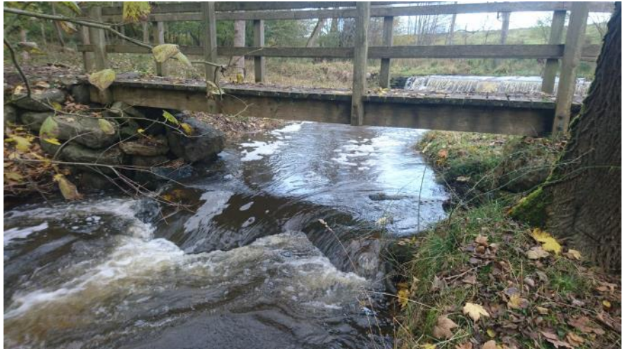
Figur 3.20: Ca. 14 meter nedstrøms overløbet er stien ført over vandløbet via et spang der ligger af på kampesten på begge sider af vandløbet. Spanget er af nyere dato. Der afvikles 10 cm fald på 10 cm under broen over et styrt opbygget af kampesten. Foto: NIRAS 2017-11-15
