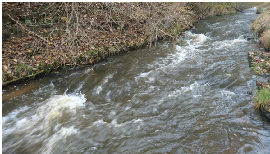
Figur 3.15: Omløbet er hugget ud i den underliggende skifferbund og vandløbets bund består derfor af glatte skifferplader hvilket giver en meget høj vandhastighed i omløbet, specielt på den nedstrøms halvdel af omløbet. Der er meget få sten i vandløbet til at bryde strømmen. Foto: NIRAS 2017-11-15
