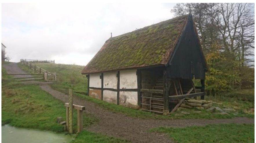
Figur 3.5: Afløbet (slusen) til møllen ses i nederste venstre del af fotoet. Oversiden af sluse (overløb) blev indmålt til kote 2,83. Bund af sluse indmålt til kote 0,83. Møllehjulet ses på den gavl der vender hen mod kameraet. Møllen er af underløbstypen. Foto: NIRAS 2017-11-15
