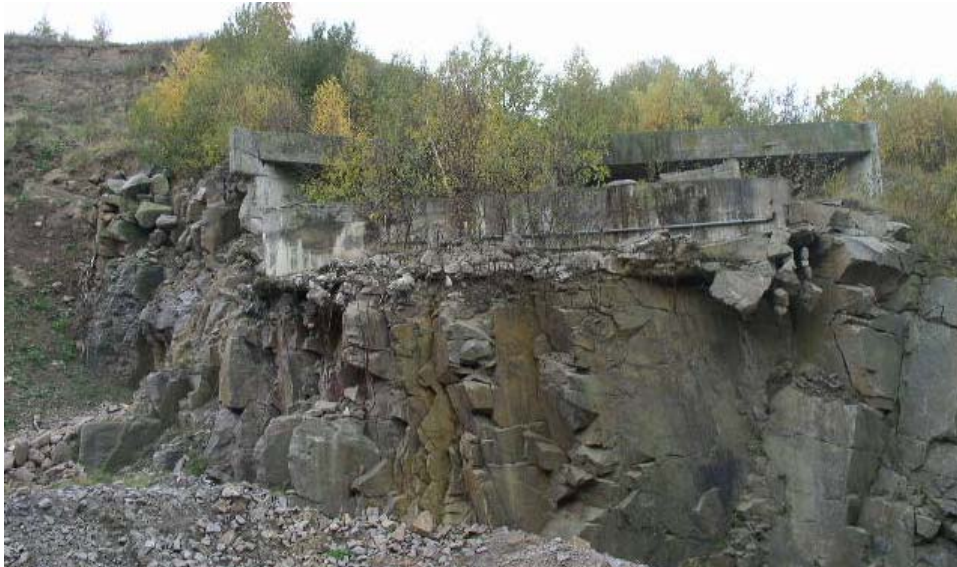
Betonfundamentet og indgangen til de underjordiske rum og gange
