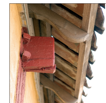
Udhæng på bindingsværkshuse - ikke synligt undertag
