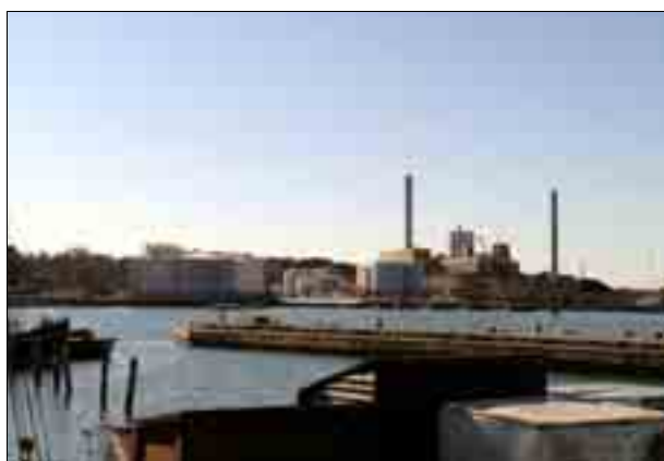
Sydhavnen med olieanlæg og Østkraft
