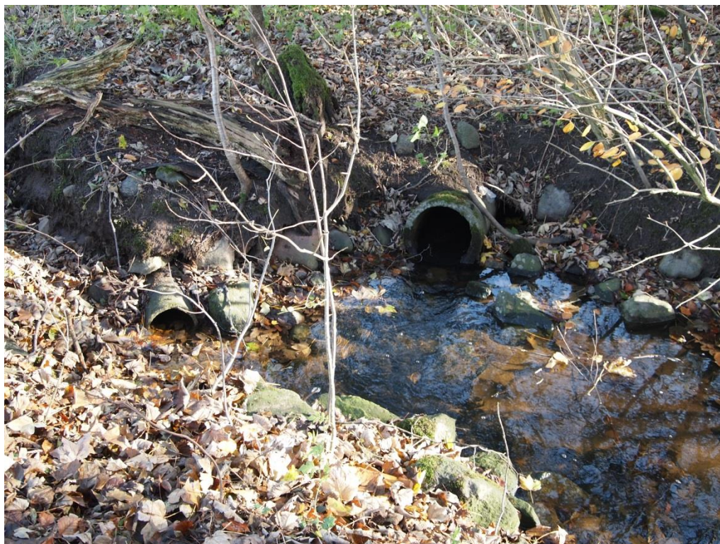
Figur 5.6: Rørudløb i projektarealets SV ende.
