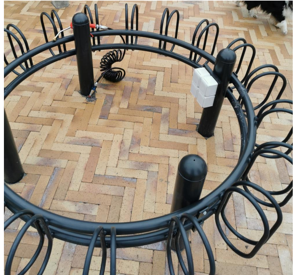
Eksempel fra Snogebæk på en ny cykelparkering med både luft og strøm til elcykler
