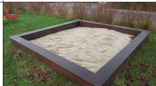
Ældre sandkasse restaureret og malet i 2007 2012 – Renoveret med støbeplade 2021 – nye kanter
