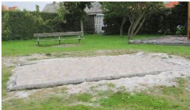
Ældre nedgravet sandkasse med betonafrænsning
