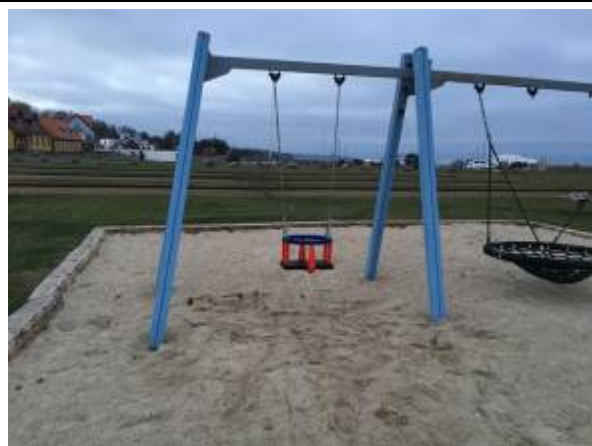
2008 - Lappset gyngestativ model 020418M med fuglerede 2016 - Babygyngende model 1264U / 1256 19 2013 – Renoveret og malet – Nye kanter 2016 – Nye kanter 2018 – Renoveret og malet 2022 – Ny fugleredegyngende 203 – obs på overhænger ift rust
