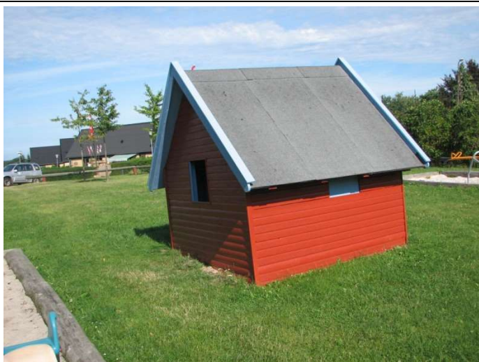
Legehus opført af borgerforening . 2013 – Renoveret og malet Kalle tjekker vedr. beklædningsbrædder
